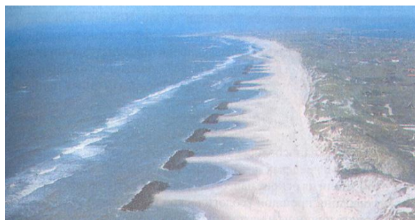
Primjer zaštite obale od erozije izgradnjom odvojenih lukobrana
